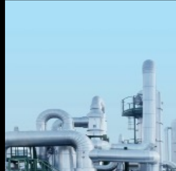
Construction d'un backbone CO 2 sur dorsale wallonne
